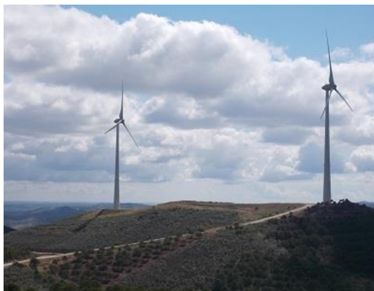
Figura 1 – Vista para área de implantação do Parque Eólico do Malhanito.
