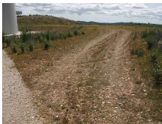
Figura 7 – Vista para plataforma do Aerogerador 19, onde foi registada a presença de rodados.
